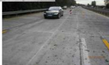
Warstwa betonu nakładana przez maszynę 1500 (Wirtgen)
