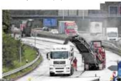
Usunięcie 10 cm uszkodzonej warstwy betonu poprzez
