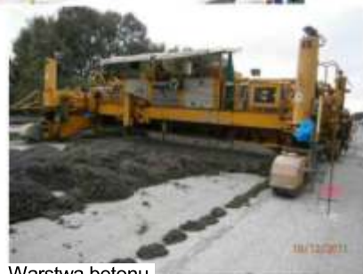
Warstwa betonu nakładana przez maszynę 1500 (Wirtgen)
